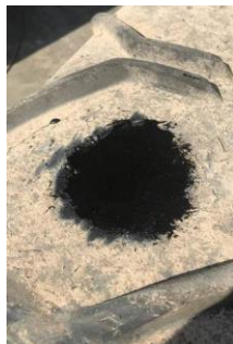
Reparation af hul
